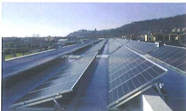
In particolare, nel 2013 si è provveduto ad installare sulla copertura del Palazzo Comunale, per un importo complessivo di € 300.000, un impianto fotovoltaico composto da 325 moduli che occupano una superficie di 530 mq per una potenza totale pari a 97,5 kW ed una produzione di energia annua pari a circa 125.000 kWh.
