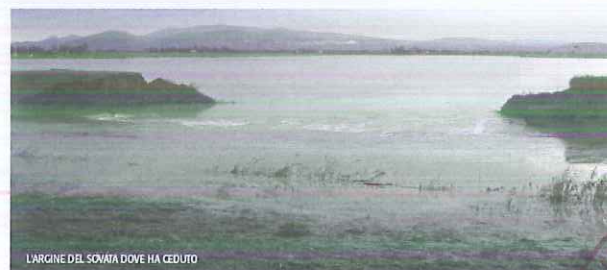
L'ARGINE DEL SOVATA DOVE HA CEDUTO
